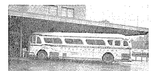
第5図 グレイハウンド遠距離用バス。床下面の凹凸はきわめて少ない。
